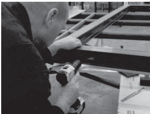
3. Vrtání otvorů pro uchycení dveřní výplně do rámu křídla dveří. Vyvrtané otvory musí mít stejný, nebo mírně větší průměr, než je průměr úchytných šroubů. Je nutno dodržet směr vrtaného otvoru kolmo na bok dveřní výplně.
