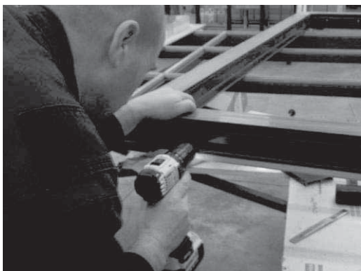
3. Vrtání otvorů pro uchycení dvevní výplně do rámu křídla dveří. Vyvrtané otvory musí mít stejný, nebo mírně větší průměr, než je průměr úchytných šroubů. Je nutno dodržet směr vrtaného otvoru kolmo na bok dvevní výplně.
