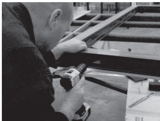
3. Vrtání otvorů pro uchycení dvevní výplně do rámu křídla dveří. Vyvrtané otvory musí mít stejný, nebo mírně větší průměr, než je průměr úchytých šroubů. Je nutno dodržet směr vrtaného otvoru kolmo na bok dvevní výplně.
