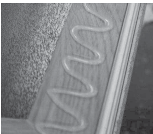
5. Nanesení silikonu na rám křídla dveří a jeho rovnoměrné rozetření.
