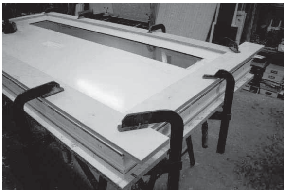
7. Tlaková fixace dveřní výplně k rámu křídla dveří. Základní očištění od přebytečného silikonu.
